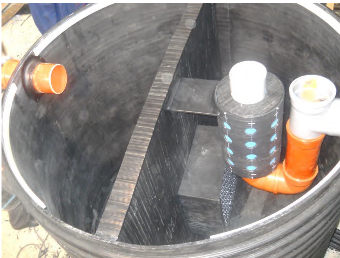
Slika 15. Prikaz preseka separatora
